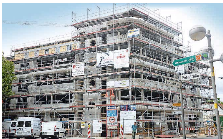
Am Völklinger Carré an der Ecke Poststraße und Bismarckstraße wurde erst unlängst Richtfest gefeiert. Nun soll ein 2,8 Millionen-Kredit für den Weiterbau aufgenommen werden. Foto: Jenal
